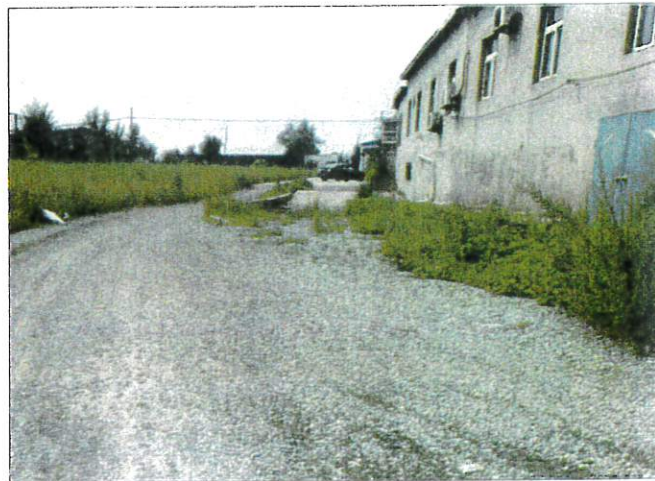
图 3 斜井区围墙外进场道路碎石路面现状图
