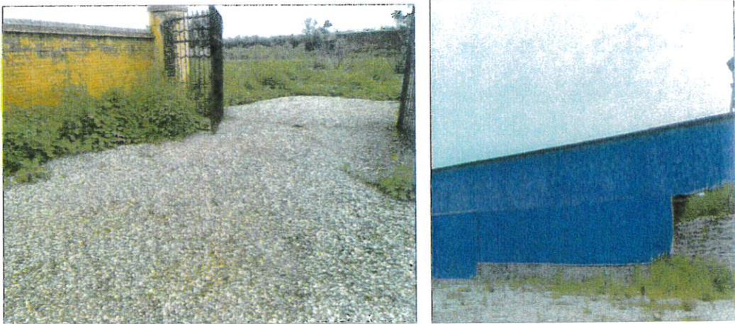
图 9 主井区院内碎石路面现状图
