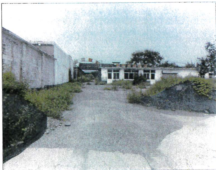
图4 斜井区西南角碎石路面现状图
